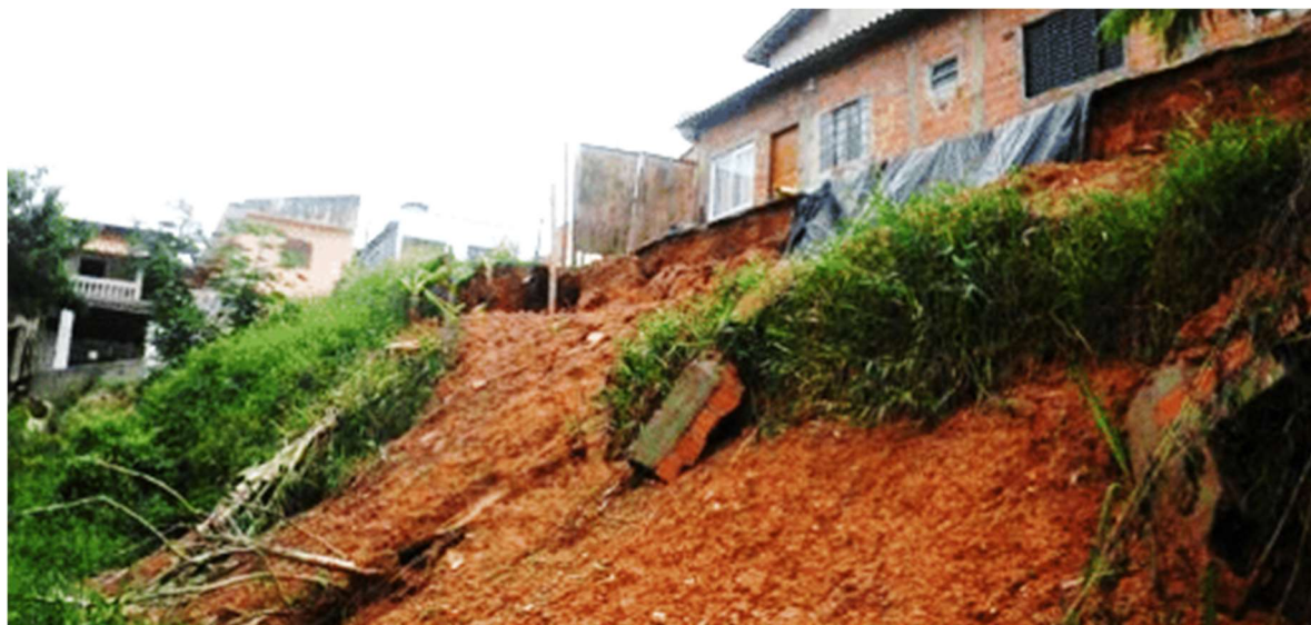
Fotografia 8 - Casa interditada em área de risco em uma vertente da Bacia do Ribeirão do Jerivá, Boituva-SP\
