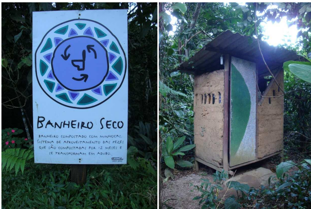
FIGURA 14 - BANHEIRO SECO IPEMA - VISTA EXTERIOR
