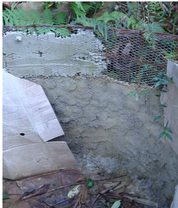
FIGURA 11 - CONSTRUÇÃO FERROCIMENTO IPEMA
