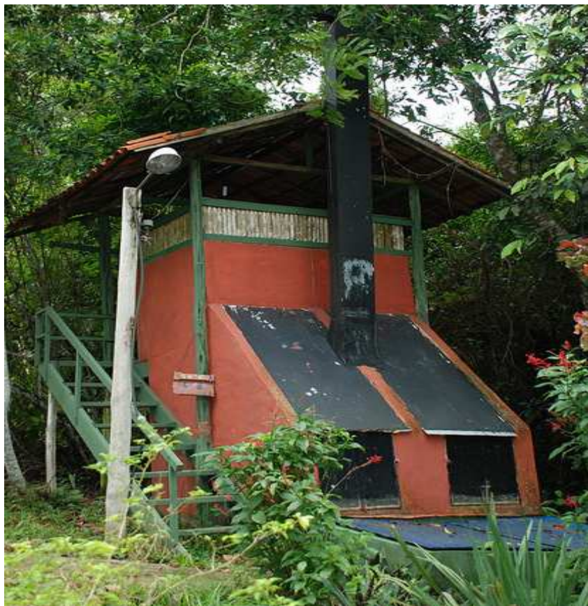
FIGURA 17 - BANHEIRO SECO DO INSTITUTO DE PERMACULTURA DA AMAZÔNIA - VISTA DAS CÂMARAS
