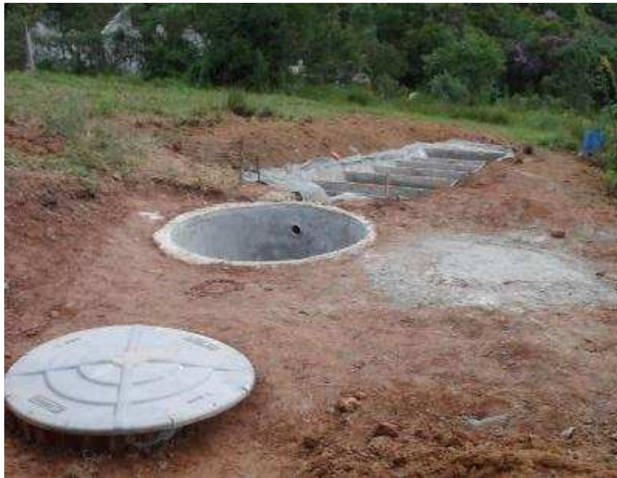
FIGURA 18 - CONSTRUÇÃO DE BIODIGESTOR
