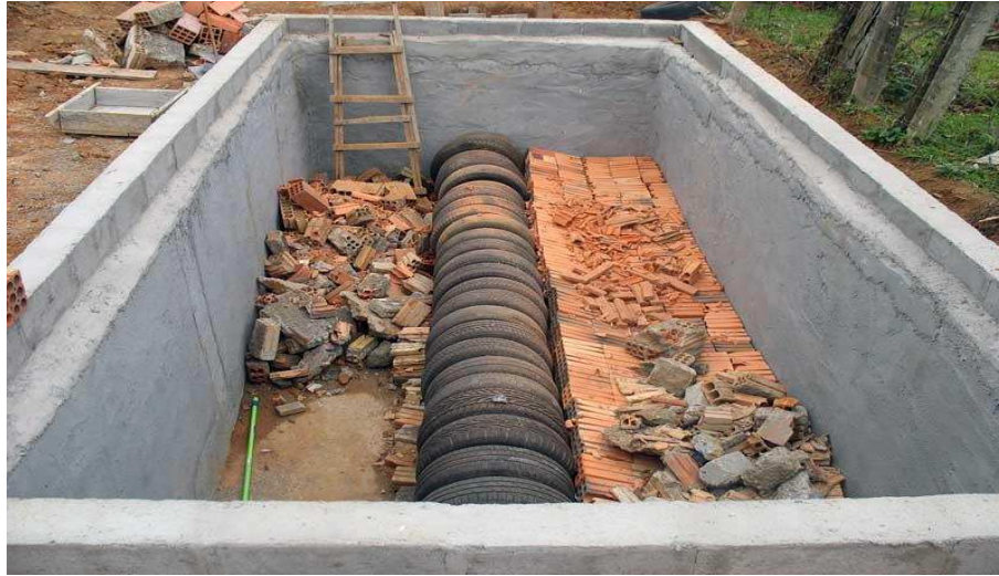
FIGURA 13 - CONSTRUÇÃO DE UMA BACIA DE EVAPOTRANSPIRAÇÃO
