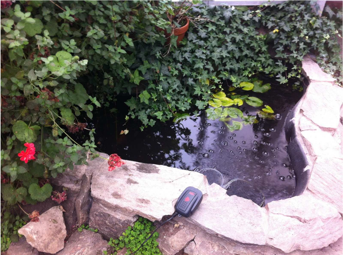
FIGURA 24 - LAGO COM ÁGUA TRATADA AO FIM DO PROCESSO DA LIVING MACHINE
