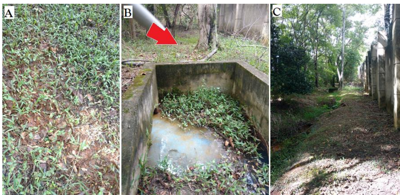
Figura 15. Local úmido o qual a nascente 9 aflora (A); afloramento evidenciado por flecha vermelha, em uma distância de menos de 5 metros da galeria de água pluvial (B); e córrego formado (C).
