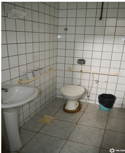
FIGURA 42 – Sanitário para pessoas com deficiência do Parque Natural Municipal Victório Siquierolli
