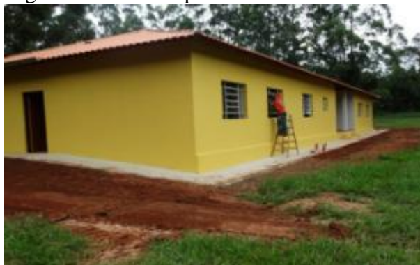
Figura 8 – Vista do prédio durante as reformas
