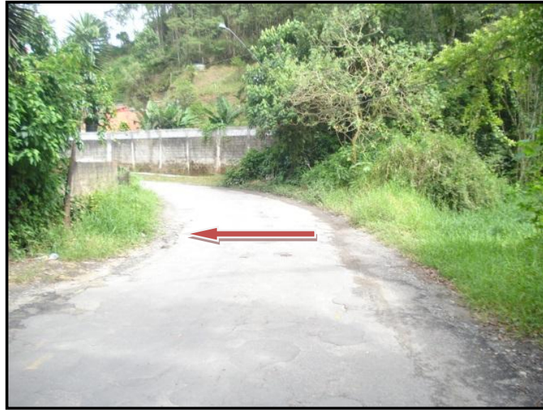
Figura 31 – Passagem do córrego sob o precário viário
