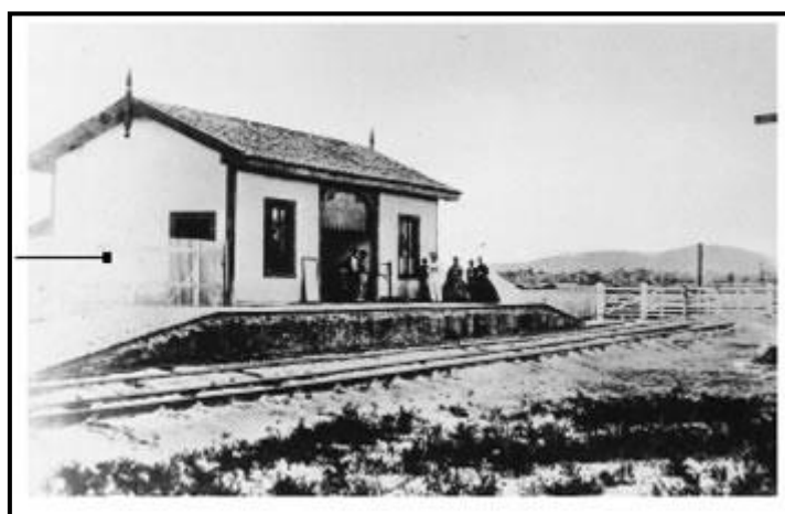
Figura 2 - Estação Ferroviária de São Bernardo, atual Santo André, em 1867
