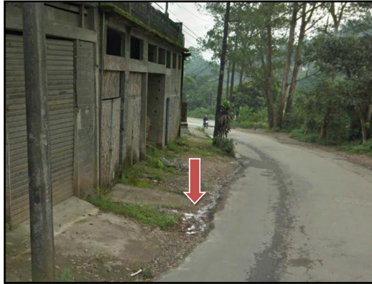
Figura 26 – Escoamento de esgoto sobre a via sem a rede de drenagem
