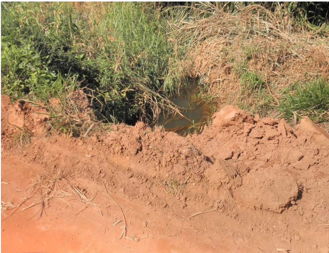
Foto 9: Setor da média bacia com afluente sendo assoreado devido a erosão do solo em suas margens. (LORCA NETO, R.O., janeiro/2012).
