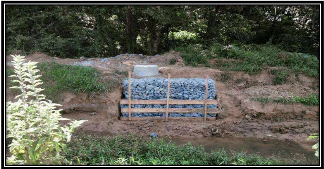
Foto-05 Muro de gabião em setor do canal no Jardim Paulistano. Autor-Custódio (junho/2012)
