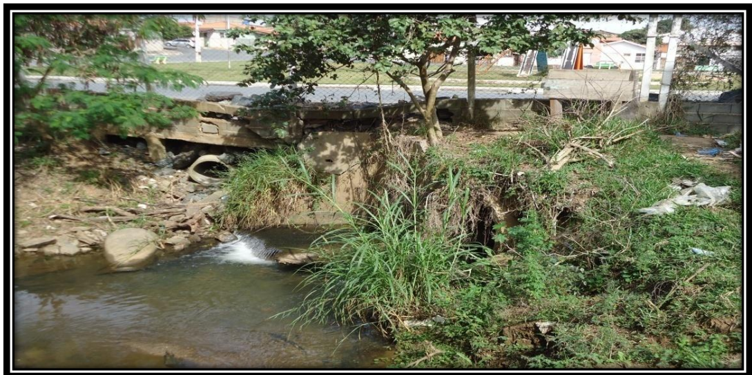
Foto 07-Confluência do córrego dos Ourives com o rio Pirapora.
