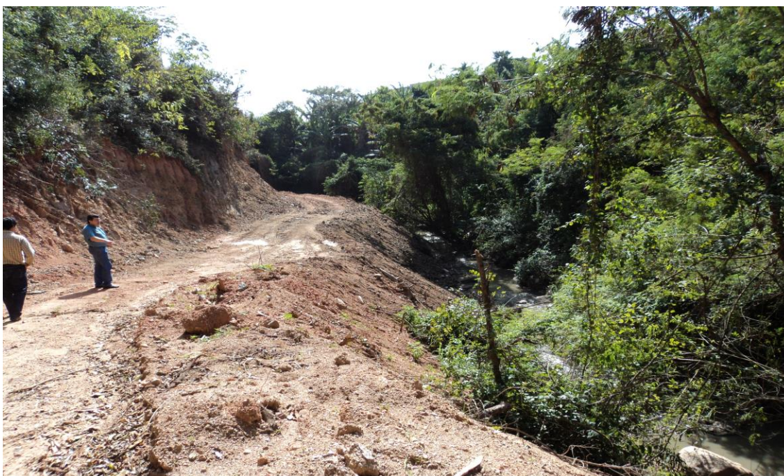
Figura 3: Terreno com talude em desmoronamento.
